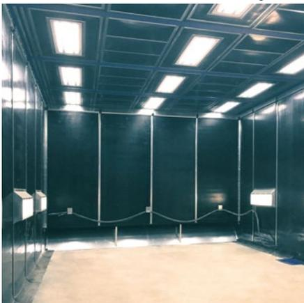
➤ Strahlkabinen mit partieller Rückgewinnung des Strahlmittels
